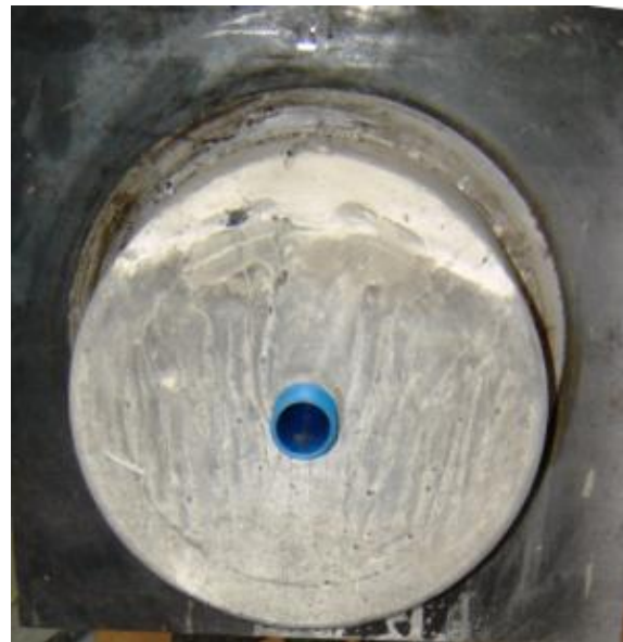
CAP protezione SERIE BASSA – riempimento con miscela cementizia
